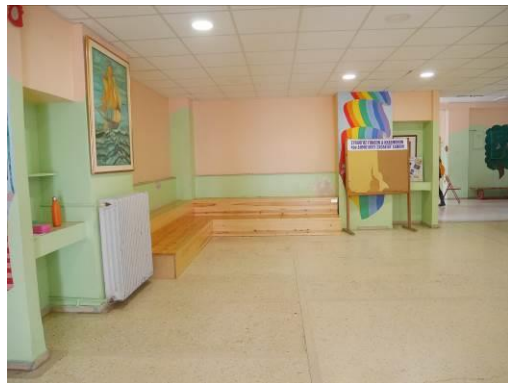
Χώρος εισόδου χωρίς φυσικό φωτισμό
