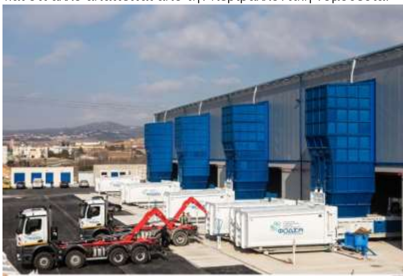
Εικόνα 21: ΣΜΑ Βορειοδυτικού Πολεοδομικού Συγκροτήματος Θεσσαλονίκης στην Ευκαρπία, κλειστού τύπου, τεσσάρων θέσεων
