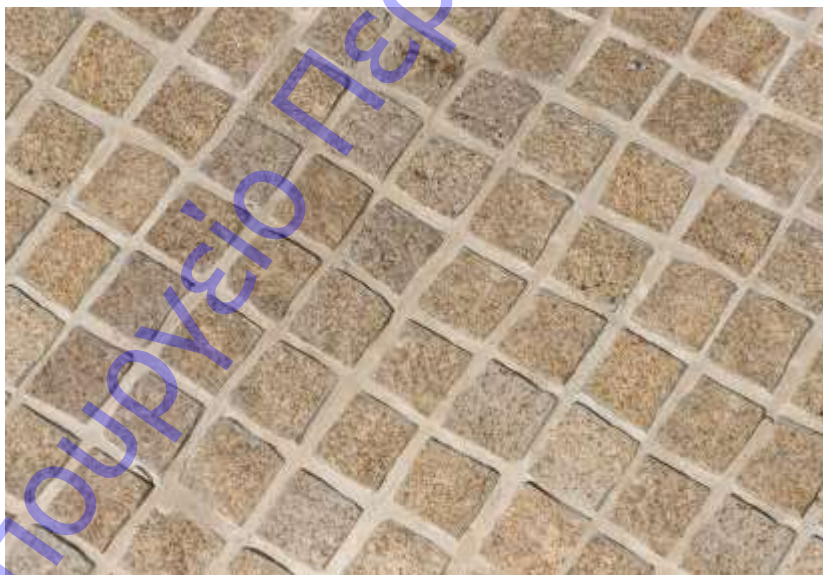
Εικόνα 13: κυβόλιθοι επικάλυψης δρόμων
