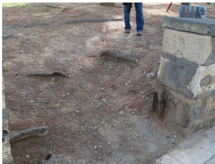
Φωτ. 3: Εμφανείς ρίζες στο έδαφος. Με την κατάλληλη επιμέλεια, μπορούν να ενσωματωθούν στην διαμόρφωση αναβαθμών, στα πλαίσια της ήπιας φυσικής διαμόρφωσης.
